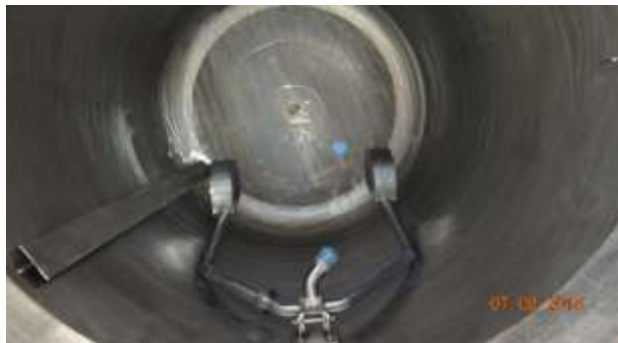
Fig. 15: Bubbler Buster Fin Inside STSC
