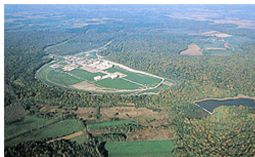
Centre de stockage de l'Aube
