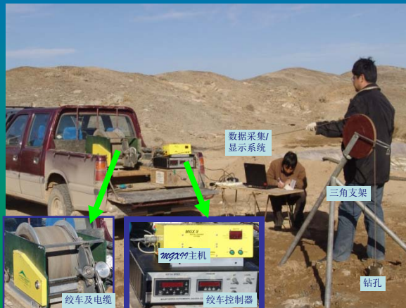
钻孔超声波电视现场测量
