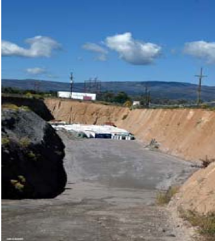
Fig. 1. LLW disposal cell
