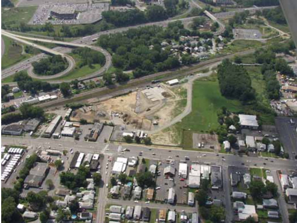
Fig. 1. Colonie FUSRAP site aerial photo
