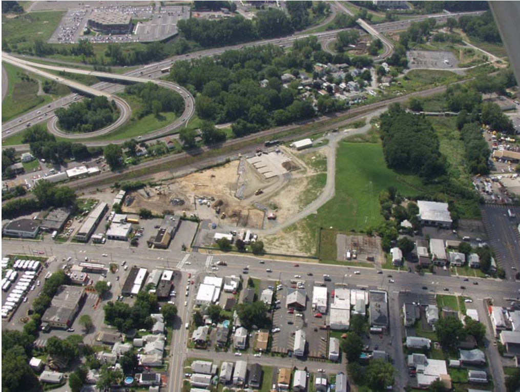
Fig. 1. Colonie FUSRAP site aerial photo
