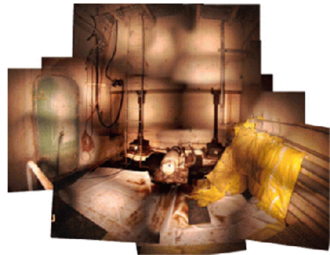
Fig. 2. GCR Shield Door Repair
