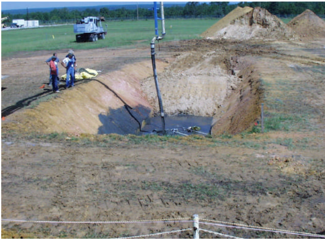
Fig. 4. Final Grout Pour to Encapsulate Spent Solvent Trailer.
